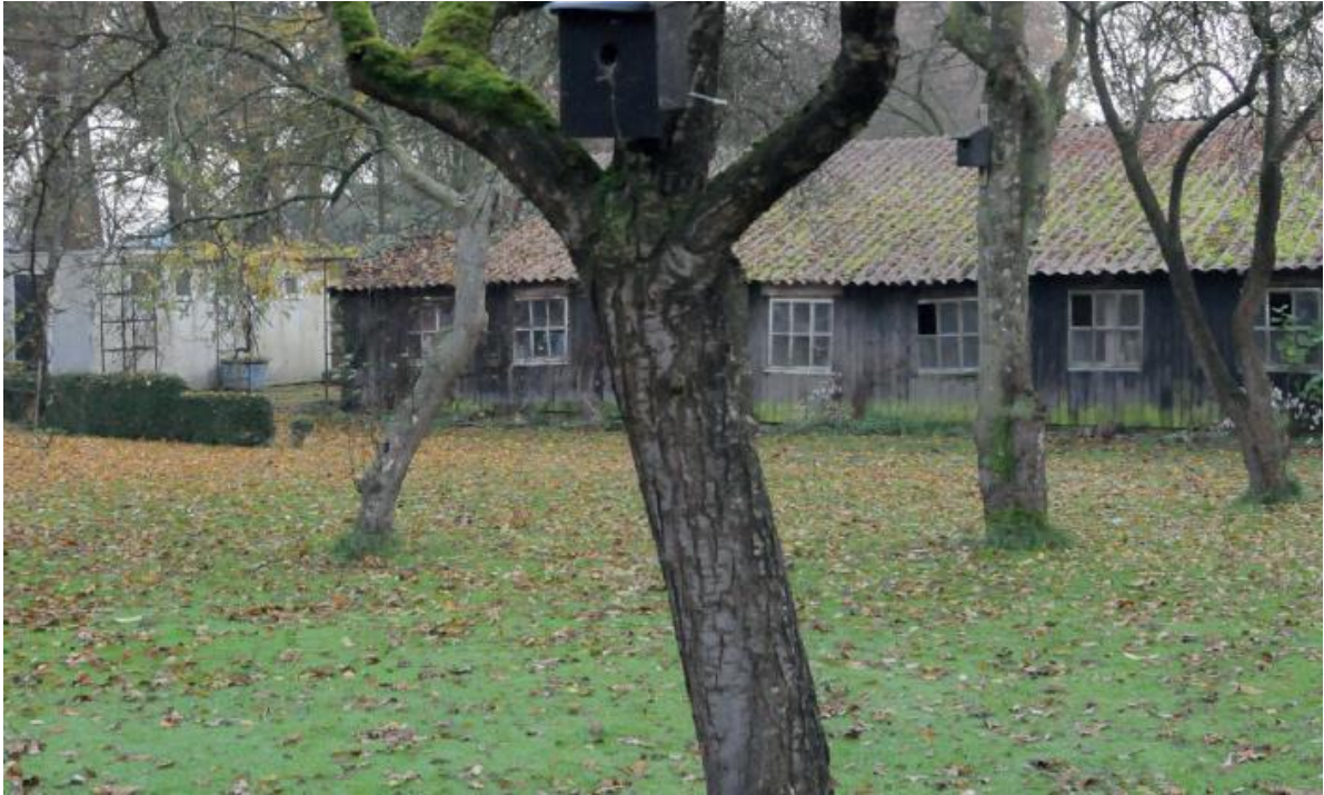
Figuur 8: Foto van de te slopen schuur aan de Liederholthuisweg 9
