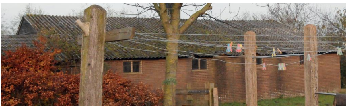
Figuur 6: Foto van de te slopen schuur aan de Raalterweg 25
