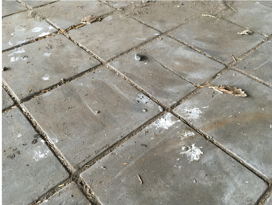
Figuur 12. Vloer van de kapschuur met uitwerpselen en braakbal kerkuil.
