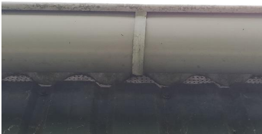
Afbeelding 4. Golfplatendak met ruimte onder de golven afgedekt met roosters.
