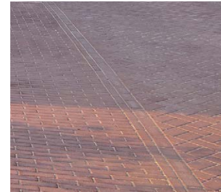
Parkeervakken worden op subtiel wijze aangeduid, door middel van een ander legverband
