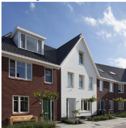
Rijwoningen hebben per blok één accent, zoals een kapverdraaiing en/of onderscheidende gevel
