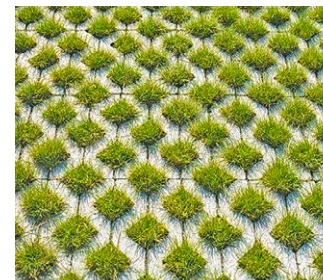
Grasbetonsteen bij parkeervakken in parkeerkoffer
