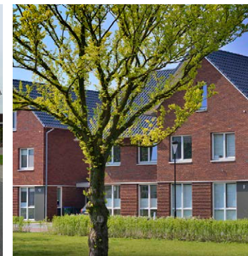
De bebouwing is uitgevoerd in terughoudende kleuren, waardoor het groen op de voorgrond staat
