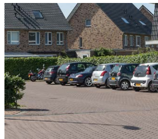
Rijbaan parkeerkoffer in betonstraatsteen
