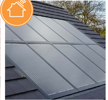
Zonnepanelen in het dakvlak
