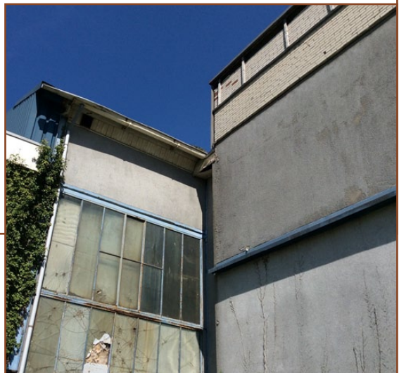
Afb. 3.3: Metselwerk aan de bovenzijde van de fabriekshal.
