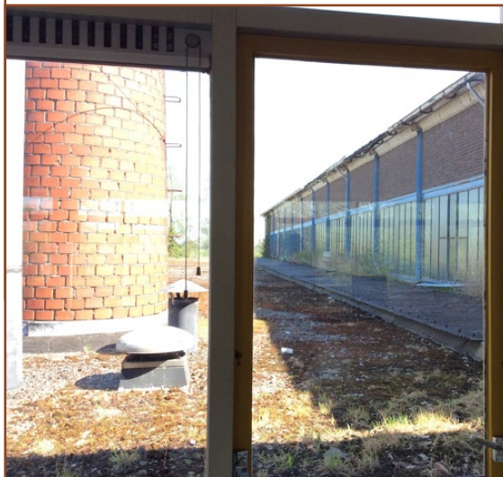
Afb. 3.2: Stenen muren en ander metselwerk kan geschikt zijn als verblijfplaats vleermuizen.
