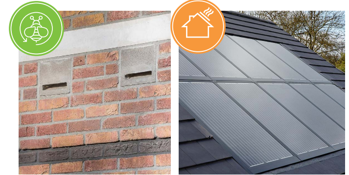
Inbouw vleermuiskasten
