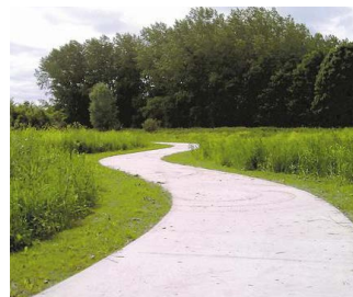
Fietspad van gerecycled beton
