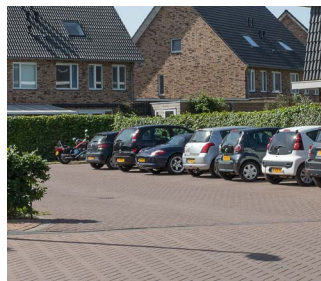
Rijbaan parkeerkoffer in betonstraatsteen
