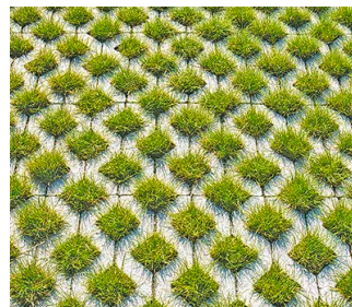
Grasbetonsteen bij parkeervakken in parkeerkoffer
