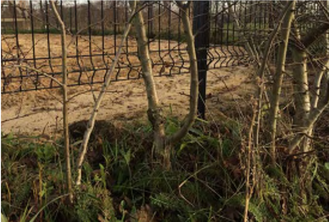
Afbeelding 30. Faunapasseerbaar hek, op enkele decimeters van de grond vastgemaakt (ander type hekwerk maar het juiste principe)
