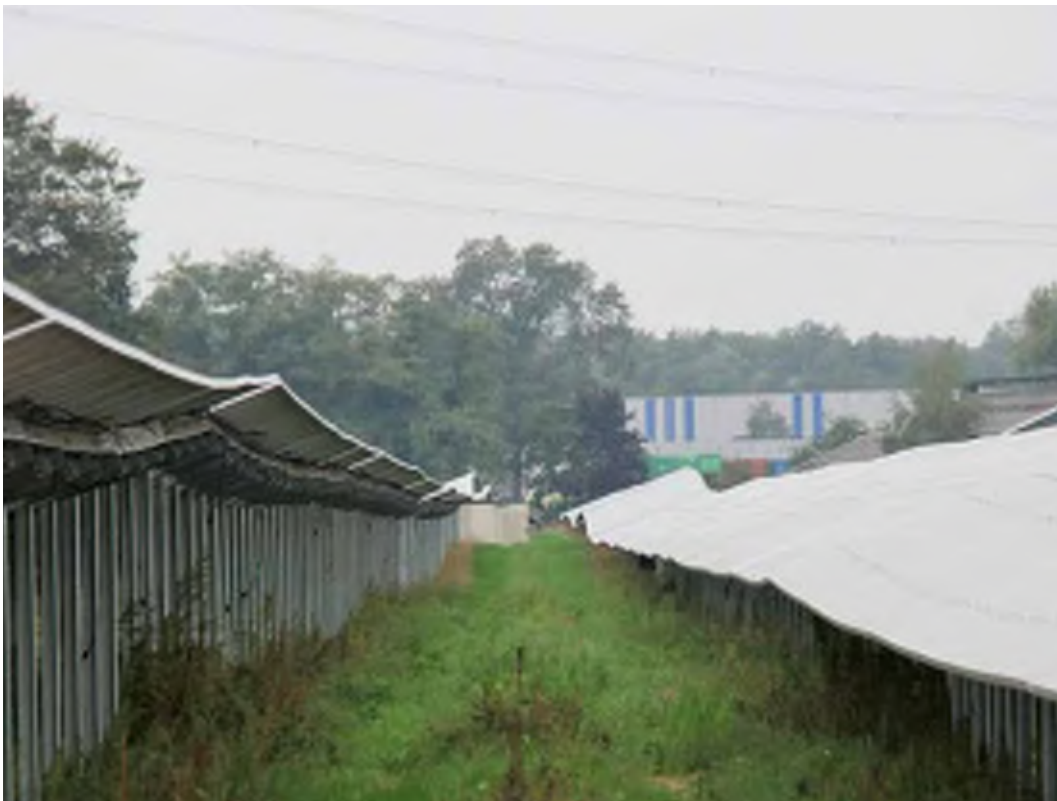
Afbeelding 23. Ongewenst voorbeeld plaatsing zonnepanelen op ongelijke hoogte
